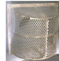
循环泵入口玻璃滤网
